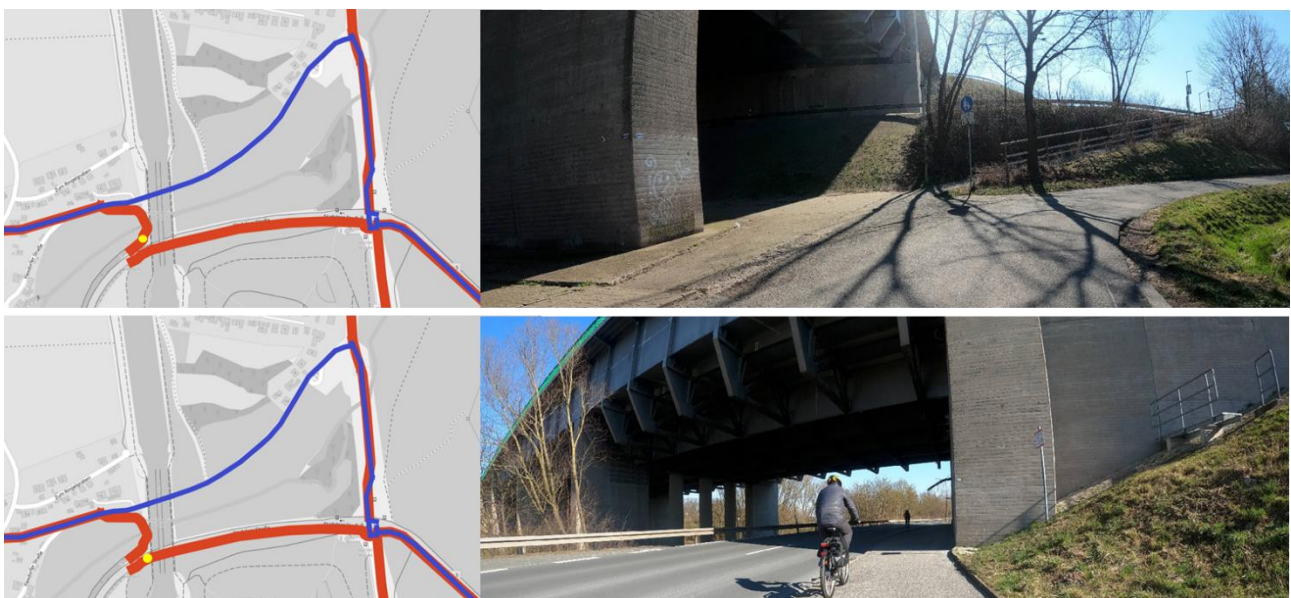
Abbildung 60: Vorrangroute 7 (oben: Rampe zur Stadelner Str., unten: Stadelner Str. mit Trogbücke Main-Donau-Kanal) - Fotos aus der Befahrung
